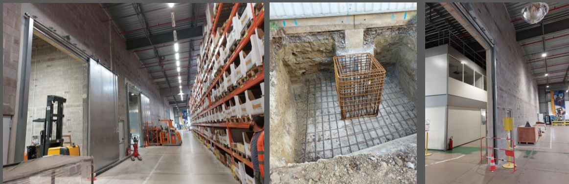
Epuration d'effluents industriels Usine de BOISTHOREL – RAI (61)
