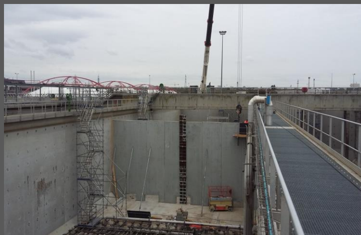
PAROI SEPARATIVE HAUTEUR 9M STEP VALENTON (94)
