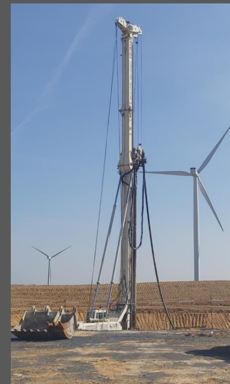
Pieux sous massifs d'éoliennes GUEUDECOURT (80)
