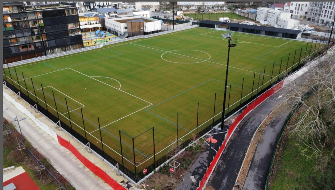
Voile de soutènement en périphérie du terrain MONTREUIL (93)
