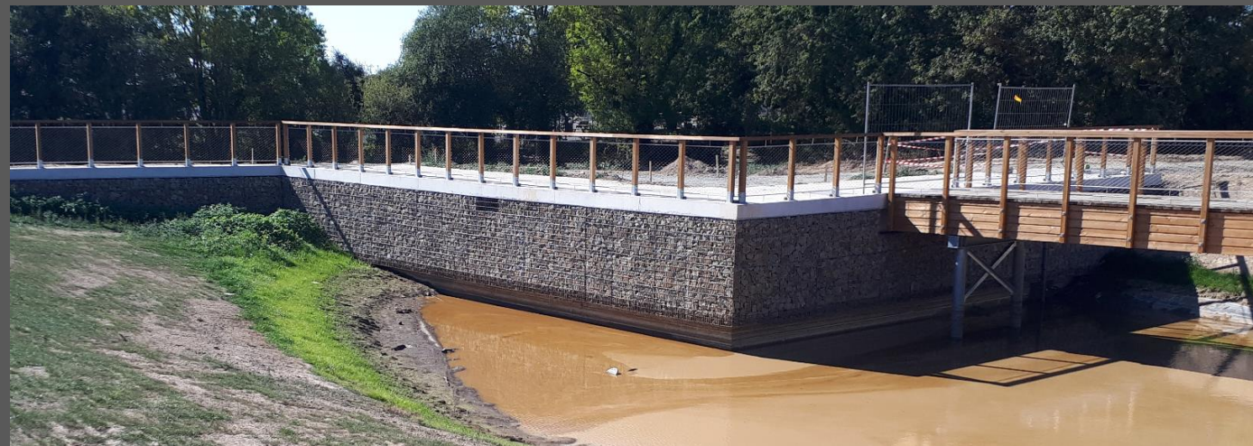
BASSIN ST ETIENNE DE MONTLUC (44)
