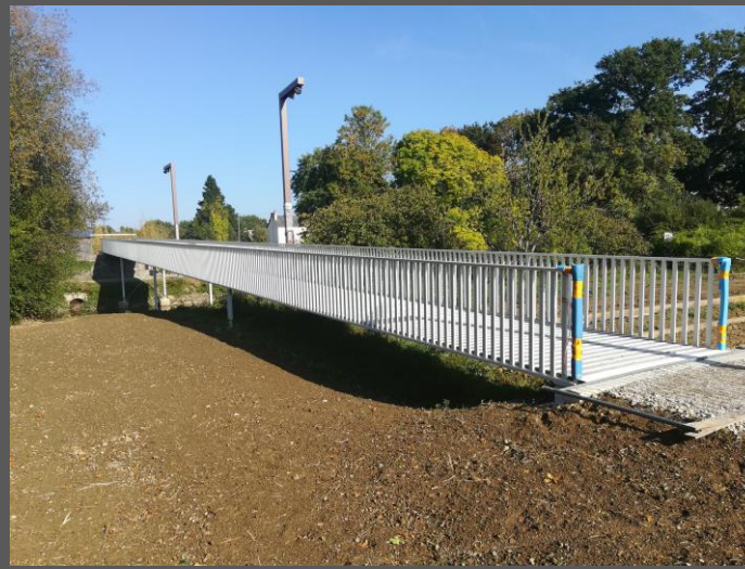
PASSERELLE DE LA MOTTE BRULON – RENNES (35)
