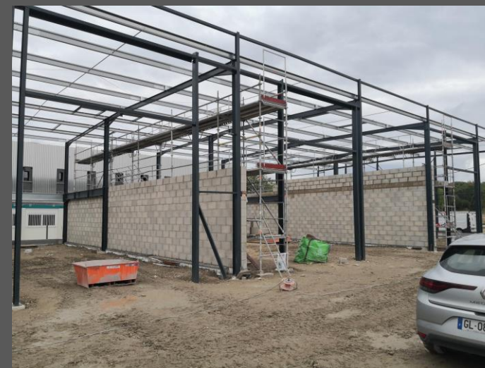
Bâtiment bureaux ACHERES (78)
