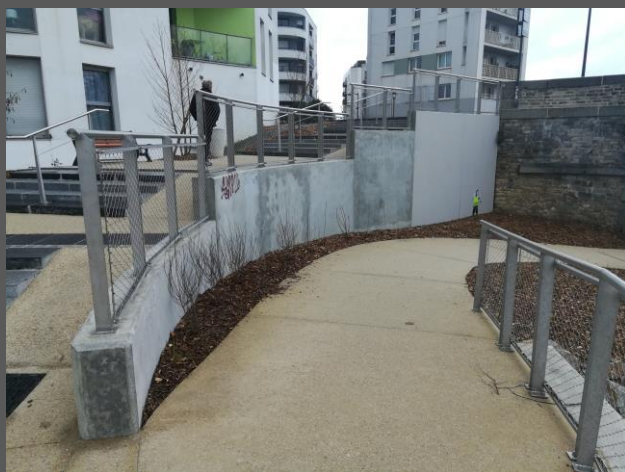
PROMENADE DES BONNETS ROUGES MUR DE SOUTÈNEMENT – RENNES (35)
