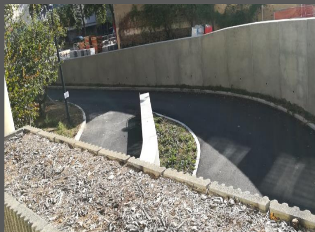
Mur de soutènement Accès parking place Colombes RENNES (35)
