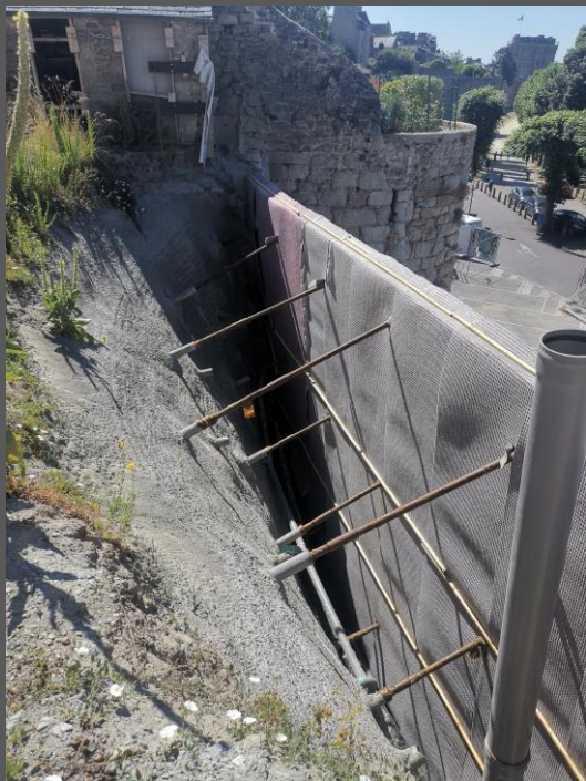
Voile de soutènement avec tirants CONFORTEMENT ENCEINTE VILLE DE DINAN (35)
